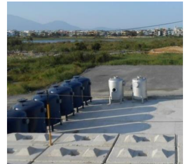
Các bể GAC được đưa đến công trường (Ảnh: CDM Smith)
