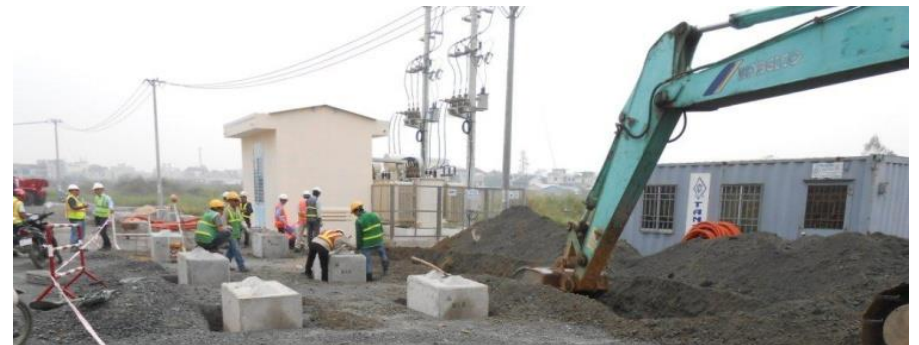
Lắp đặt đường dây dẫn điện phục vụ hệ thống xử lý (Ảnh: CDM Smith)
