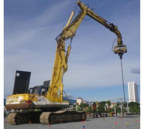
Lắp đặt ống truyền nhiệt vào kết cấu móng (Ảnh: CDM Smith)
